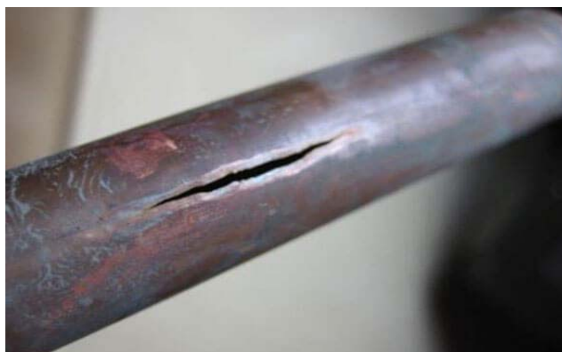
Рисунок 1 – пример распространения трещины
