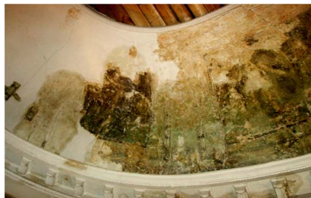
Рис. 3. Фото падуги (нижней части плафона) в процессе реставрации.. (Фото автора).
